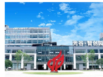
中电光谷产业园
